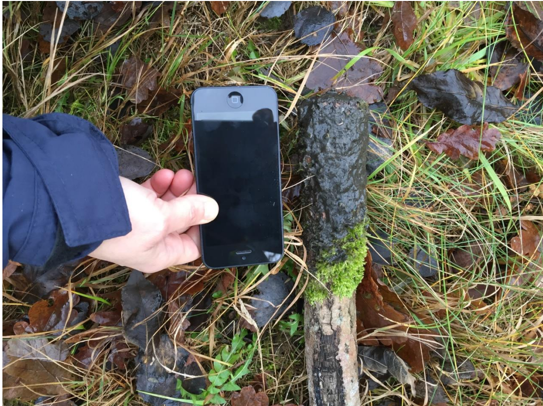
Bild 38 Slam i luftarrör på markbädd
