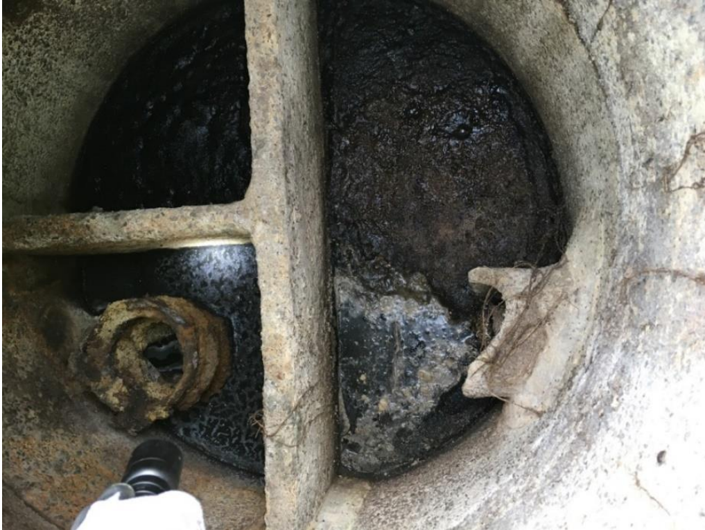
Bild 33 Äldre återvänd slamavskiljare
