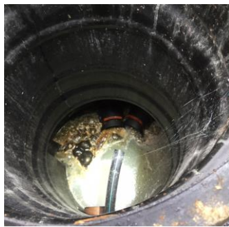
Bild 25-27 Tre exempel på slam i fördelningsbrunn. De två längst till vänster har slam som ligger på ytan och som kan vara en potentiell risk för att komma ut i spridningsledningarna och sätta igen dessa. Fördelningsbrunnen längst till höger har ett kolsvart (förmodligen anaerozt) slam i botten av fördelningsbrunnen.
