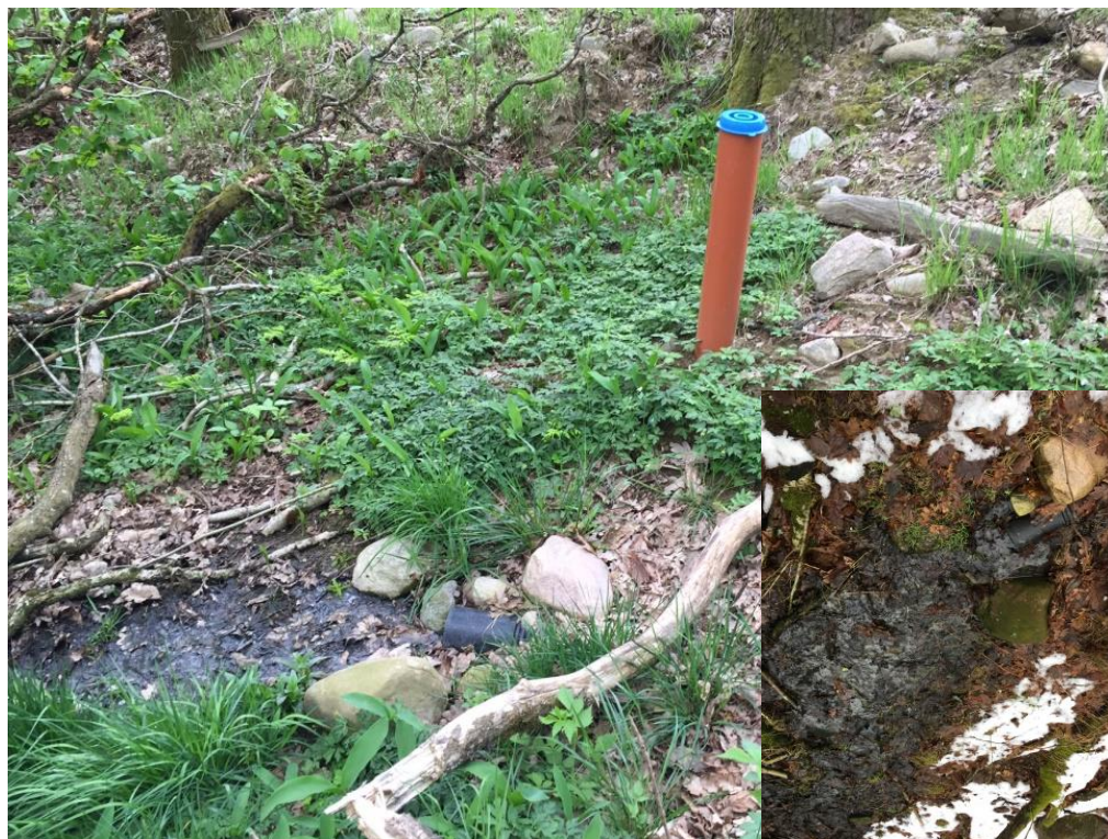
Bild 23 Anläggning 3, maj 2016. Grundvattenrör överst i bild. Svart dränledning (i nedre delen av bilden) som mynnar nedströms infiltrationen. Den är lagd ovanför och vid sidan av anläggningen i syfte att vara en avskärande dränering som fångar ytvatten som annars riskerar belasta anläggningen. Infälld bild i nedre höger hörn visar utloppet från dräneringsröret i mars 2017.
