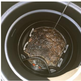
Bild 25-27 Tre exempel på slam i fördelningsbrunn. De två längst till vänster har slam som ligger på ytan och som kan vara en potentiell risk för att komma ut i spridningsledningarna och sätta igen dessa. Fördelningsbrunnen längst till höger har ett kolsvart (förmodligen anaerozt) slam i botten av fördelningsbrunnen.
