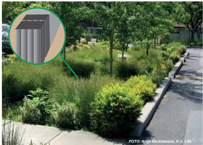
Vattenbädd som utförts som planteringsbädd med anslutet BIO-BLOK® dagvattenmoduler.
