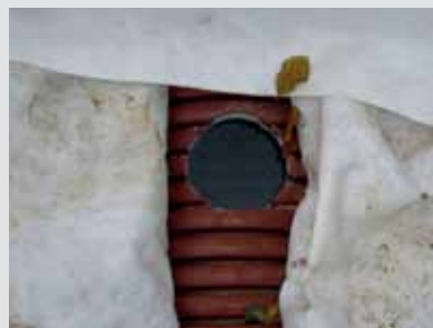
Förslag/exempel på förstärkning av sidorna med plastarmeringsnätet EXPO 1211 Std.
