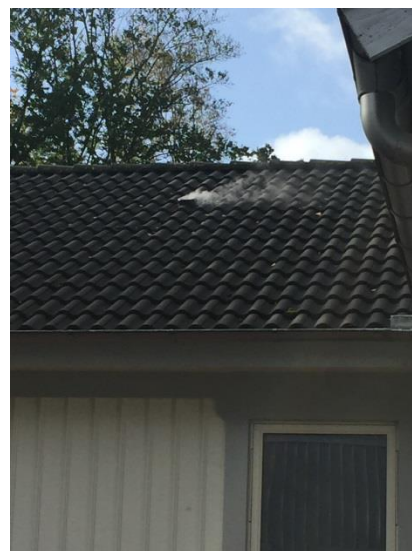
Bild 19-20 Avluftningen kan se olika ut beroende på husets ålder. Till vänster avluftning övernock på 60-talshus. Till höger hus byggt på 2000-talet. Avluftaren ligger infälld i taket.
