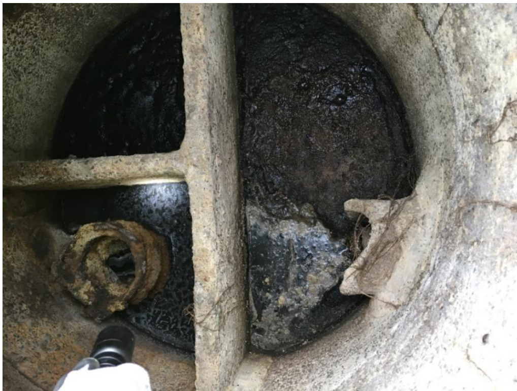
Bild 33 Äldre återanvänd slamavskiljare
