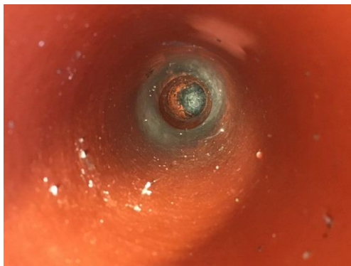
Bild 28 Exempel på luftningsrör med slam.
