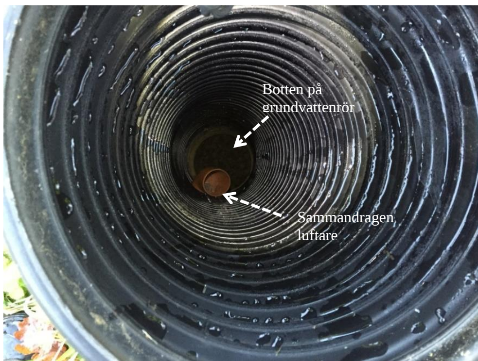
Bild 22 Grundvattenrör och sammandragna luftare på anläggning nr 18. På grundvattenröret satt ett tätt lock. Grundvattenröret var ca 75 cm för grunt. Man ser botten på röret (brunnen) och ett brunt rör som sticker ut som är luftaren.
