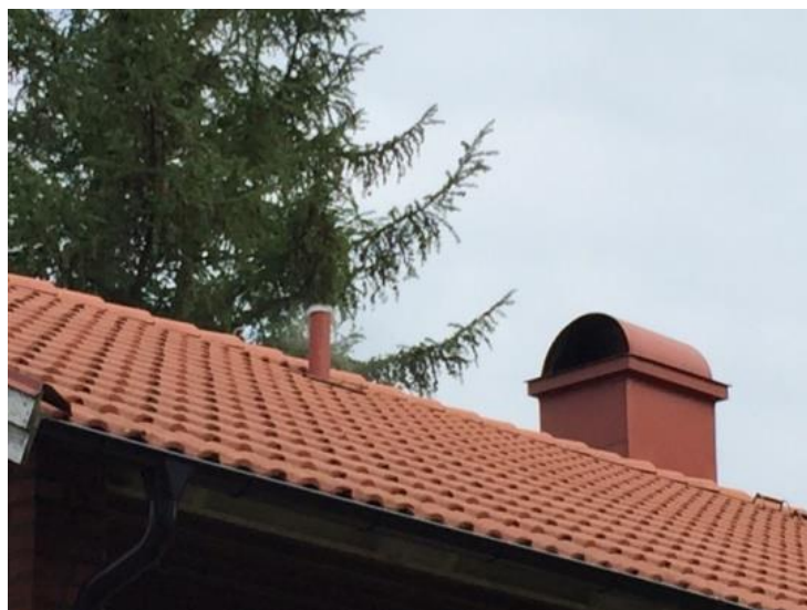
Bild 19-20 Avluftningen kan se olika ut beroende på husets ålder. Till vänster avluftning övernock på 60-talshus. Till höger hus byggt på 2000-talet. Avluftaren ligger infälld i taket.
