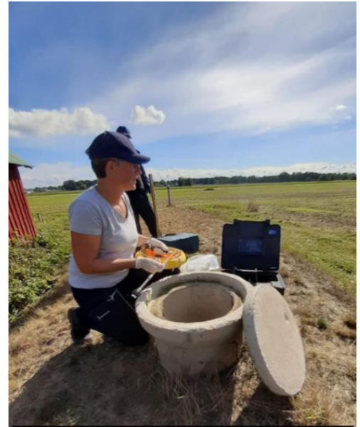
Foto: Line förbereder för kontroll med rökamera
