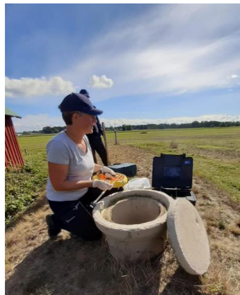
Foto: Line förbereder för kontroll med rökamera
