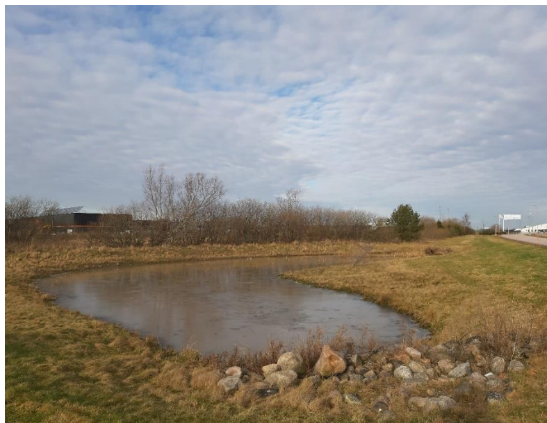
Dagvattendamm med stensatta in- och utlopp.
