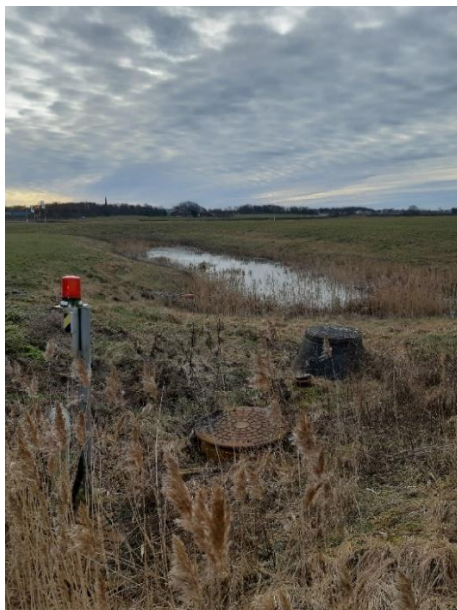
Dagvattendamm med oljeavskiljare innan utlopp i dike (foton Gun Wallnedal Enghult).
