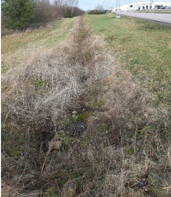
Gräsbevuxet svackdike utformat som ett infiltrationsstråk (foto Gun Wallnedal Enghult).
