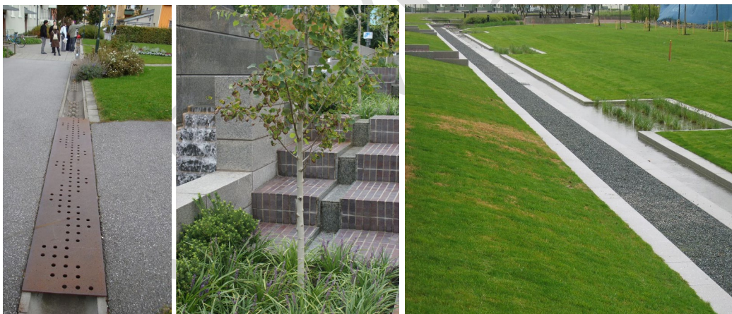
Figur 3 Exempelbilder på anläggningar för öppen, trög dagvattenavledning.
