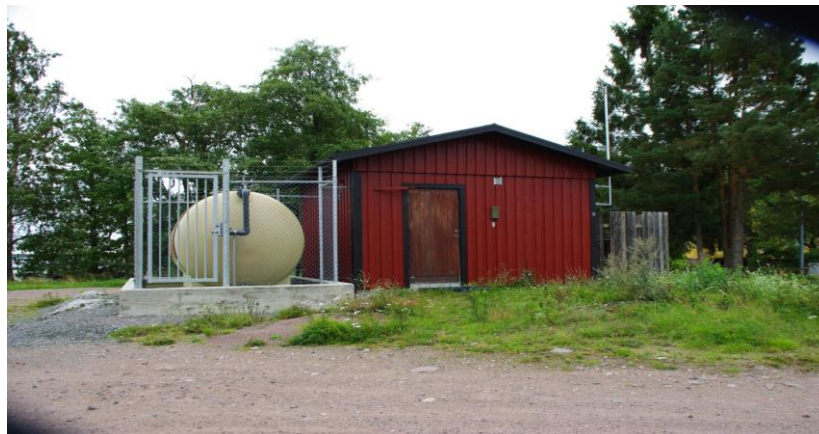
Figur 9 - Pumpstation Udden i Påskallavik
