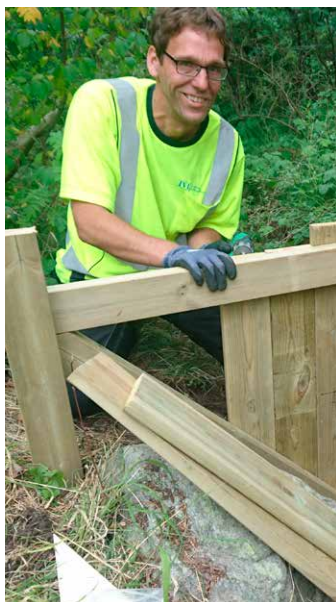
Konstruktion av överfall för realtidsmätning av flöden i diken inom Testbädd Storsudret för utveckling hållbar vattenförsörjning. Till höger en bild från hemsidan som tillhandahåller nederbörd (grön linje), ytvattenflöden (gul linje) samt grundvattennivåer (blå linje) i realtid ( https://www.ivl.se/projektwebbar/storsudret.html ).
