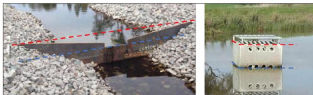
Figur 12.4 Olika utloppskonstruktioner. Blå linje: permanent vattennivå, röd linje: reglerhöjd
