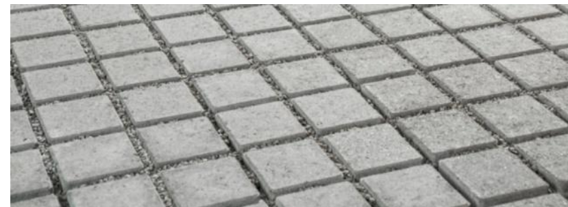
Figur 2. Exempel på dränerande markstensbeläggning. Fogarean bör utgöra minst 8–10 procent av ytan. Foto: Svensk Markbetong
