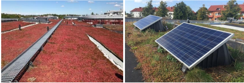
Figur 2. a) Tunna sedummattor torkar snabbt ut och bidrar inte till några ekosystemtjänster. Foto: Anne Heino. b) Gröna tak kan även kombineras med solpaneler. Foto: Jonatan Malmberg
