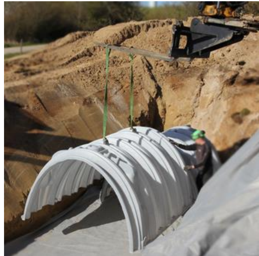
Figur 2: Visar företaget watercare's version på infiltrationsmagasin under mark. Foto: Watercare
