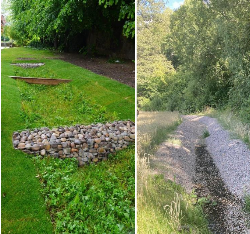
Figur 2. T.v. ett svackdike med dämnen. Dämnen ökar utjämningskapaciteten i ett svackdike. Svackdiket kan leda dagvatten till en annan dagvattenåtgärd, som svackdiket till höger som leder det till en dagvattendamm. Foto: t.v. Jonatan Malmberg, t.h. Anna Pettersson Skog
