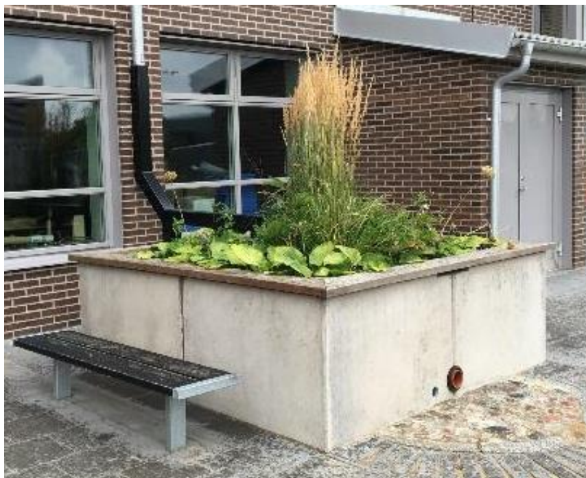
Figur 2. Exempel på upphöjda växtbäddar både på bjälklag och jordterrass för omhändertagande av dagvatten.
