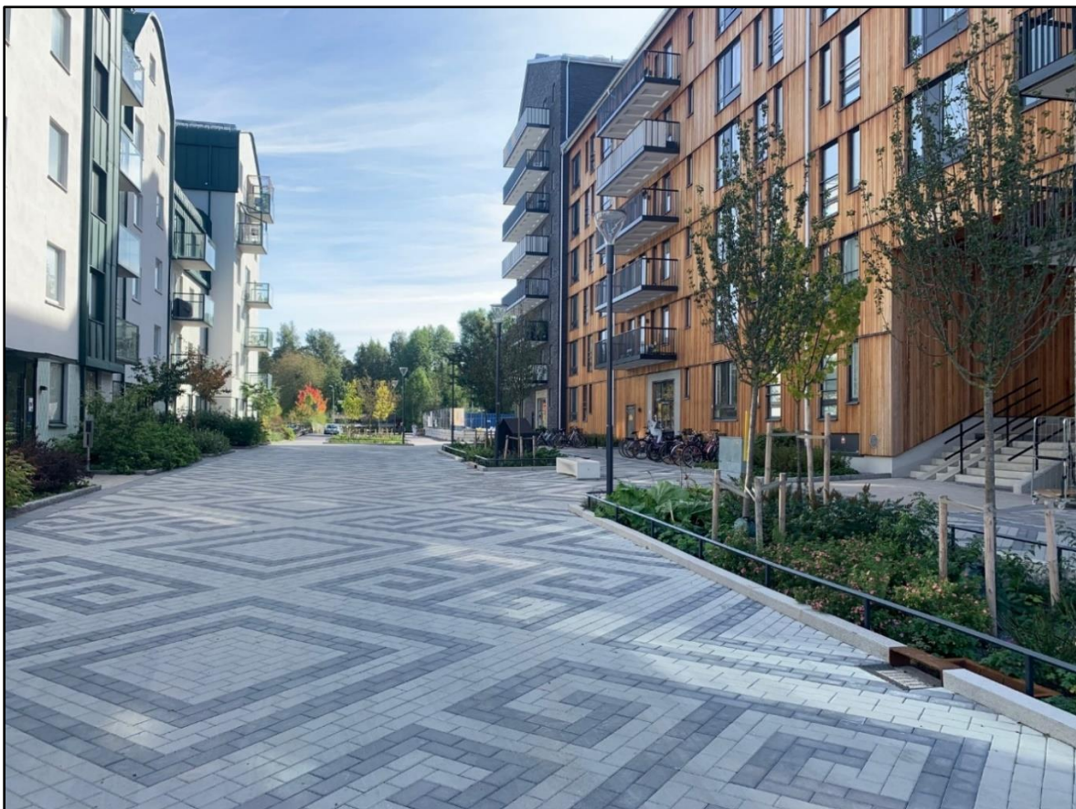
Figur 1. Amanuensgatan i Rosendal med öppet förstärkningslager i hela gaturummets bredd och med regnbäddar dit avrinningen leds (Edge).
