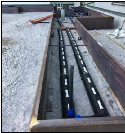
Figur 1: Ett savaq-system under uppbyggnadsfasen. Foto: NCC
