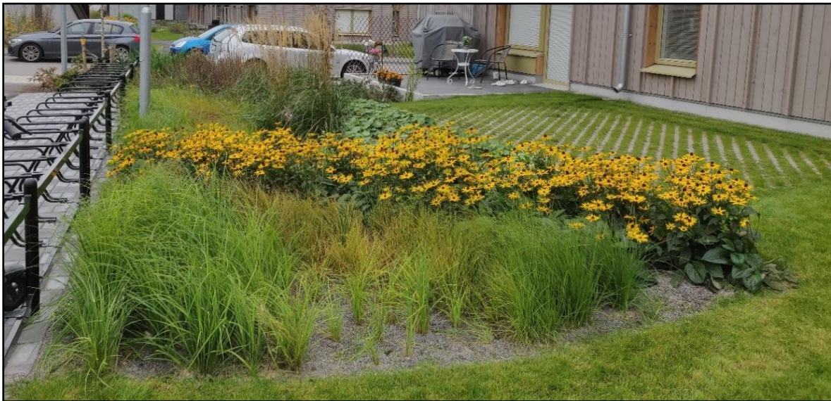
Figur 2: En av regnbäddarna i området. Gräsarmeringen bakgrunden är till för att klara brandutrymning via steguppställning samtidigt som vatten kan infiltrera i marken. Brandförsvaret kräver en hårdgjord yta för att kunna ställa upp sina stegar Foto: Uppsalahem
