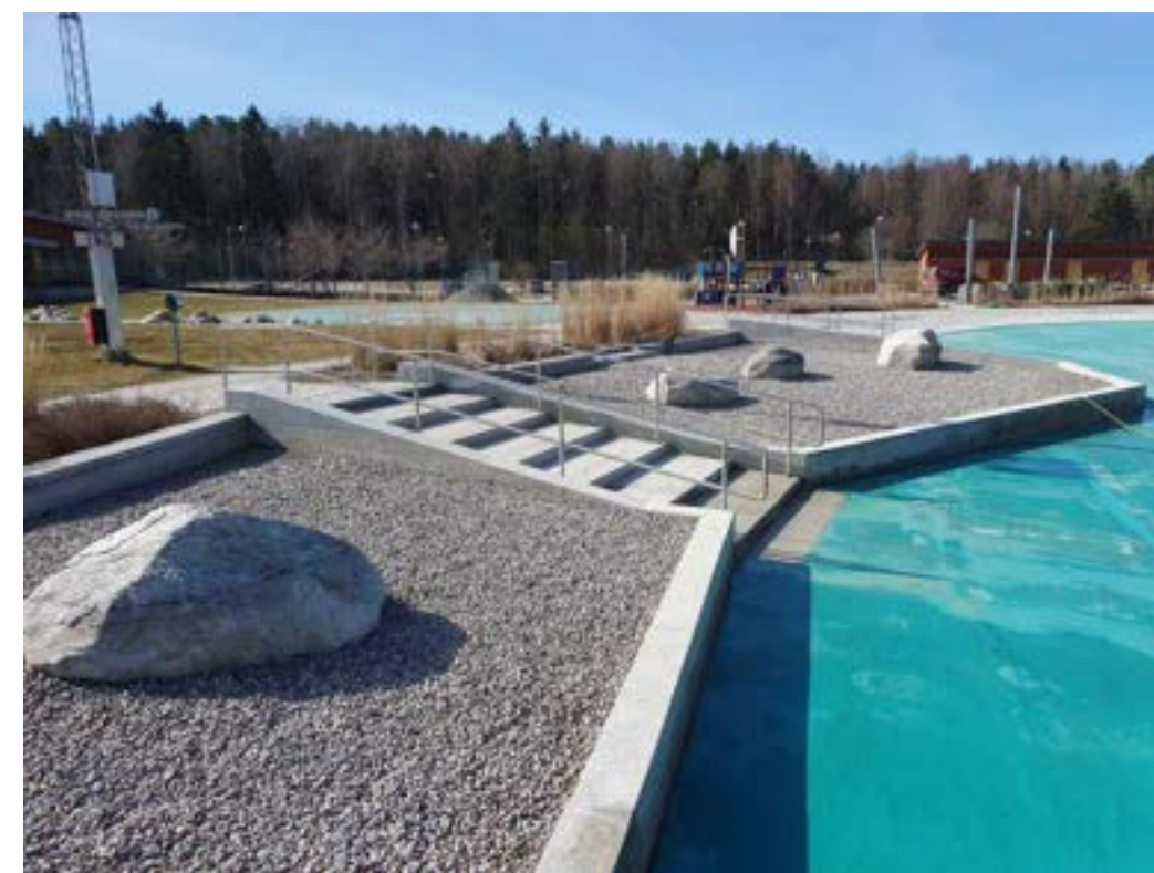
Figur 20. Fotografi på reningsfilter C. Reningsfiltret ligger in situ och saknar växter. Vattnet har tömts över vintern. [2023-04-20]
