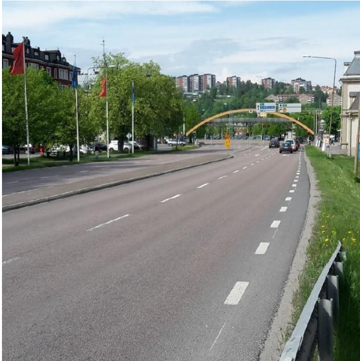
Foto: Trafikverket/Tyréns. PM avvattning väg 562 genom centrala Sundsvall
