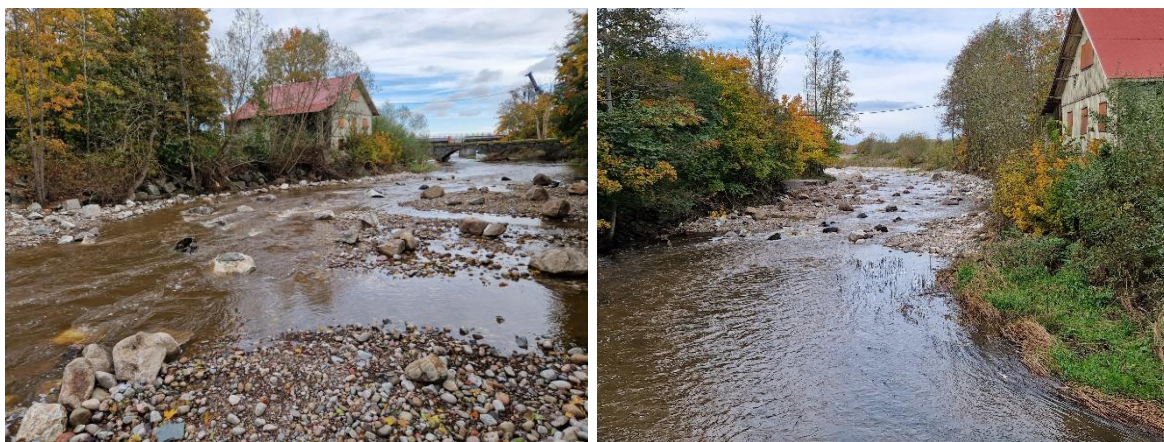
Figur 4 Efterbilder, dammen vid Almbro är utrivna och strömsträckan har biotopvårdats. Foto Norconsult 2023-10-17
