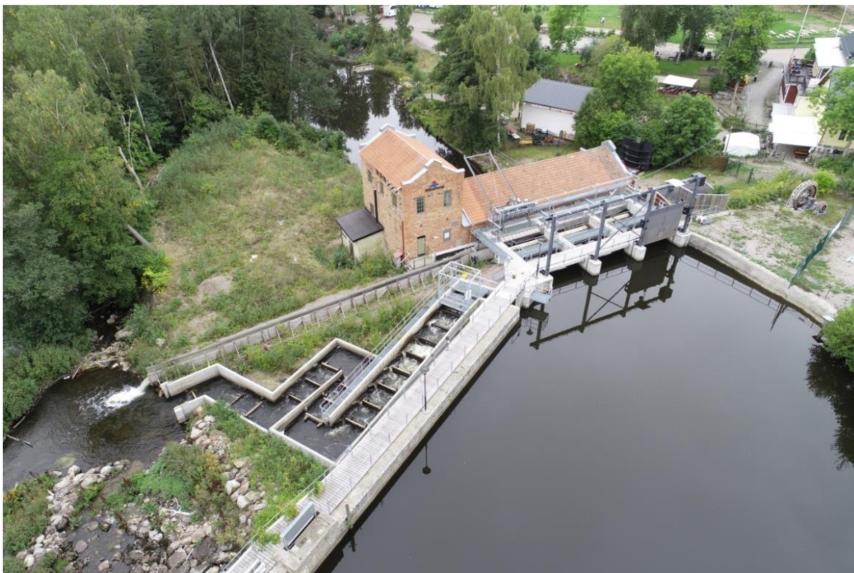
Figur 12 Slitsränna vid Västerkvarns kraftstation. Foto: Norconsult
