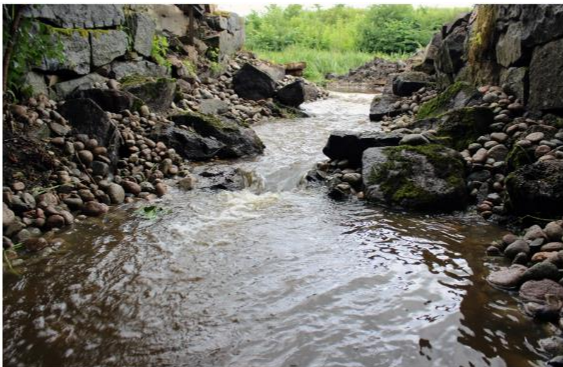
Figur 50 fiskväg skapad vid Frövikvarn i Sävaån (Sportfiskarna)
