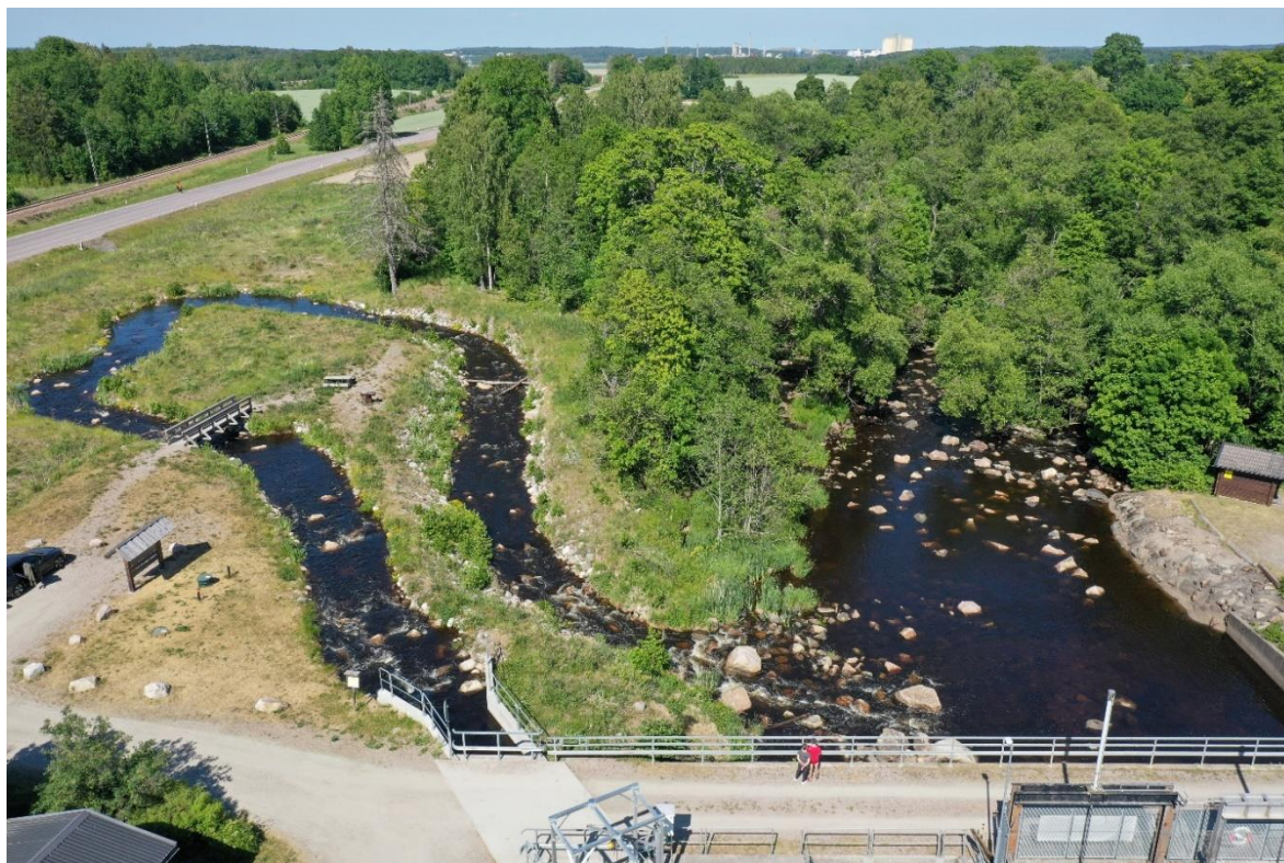
Figur 10 Omlöpet vid Östtuna kraftstation bidrar till ökning av strömsträckor i Hedströmmen (Norconsult 2023-06-15).
