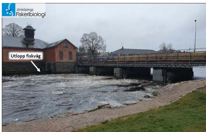
Figur 3 Fiskvägen är anlagd genom den gamla kraftstationen som inte längre är i bruk. Foto: Jönköpings fiskeribiologi
