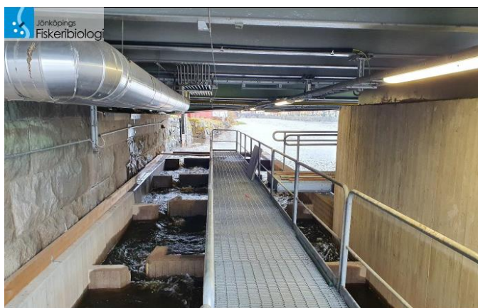
Figur 2 Dubbel slitsränna är anlagd vid centrumbron eller Herrgårdsbron. Foto: Jönköpings fiskeribiologi
