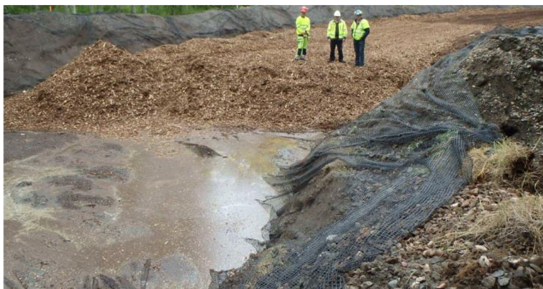
Figur 16 Fotografi från uppbyggnad av väg (Foto: Agne Gunnarsson, Trafikverket)
