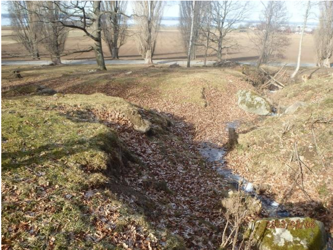
Figur 14 Fotografi över åtgärden där bäckfåran delas i två delar (Foto: Agne Gunnarsson, Trafikverket)
