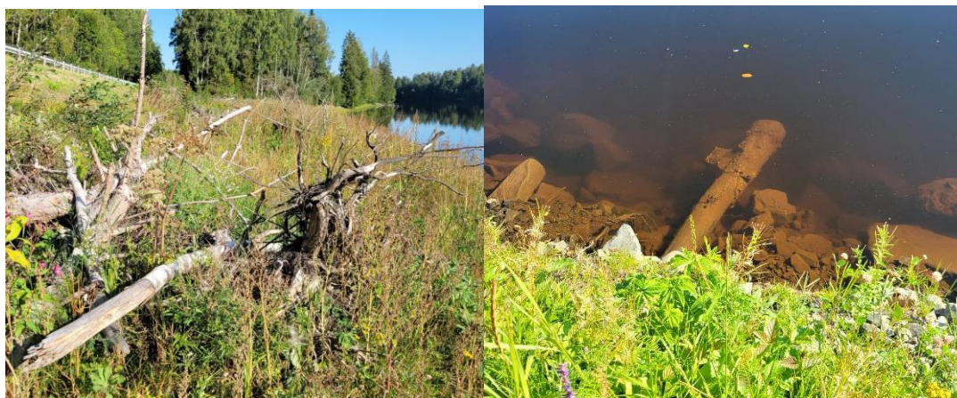
Figur 5. Död ved har tillvaratagits och placerats på skyddet (vänster bild). Sten av varierande storlek och död ved skapar håligheter undervattenytan som kan nyttjas som gömslen och boplatser för bottenfaunan (höger bild). (Foto: Anette Björlin, SGI)
