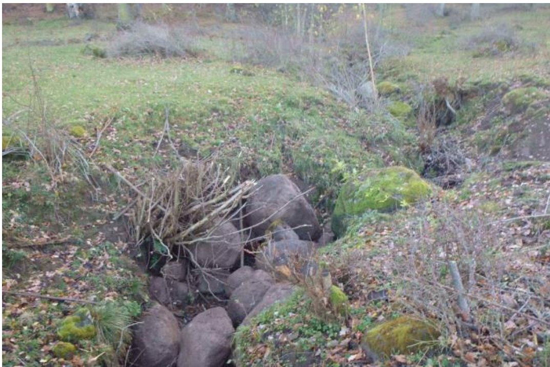
Figur 15 Stenar i bäckfåra för att minska vattnets hastighet (Foto: Agne Gunnarsson, Trafikverket)
