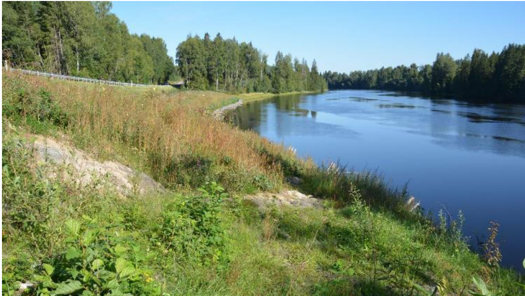
Figur 6 Tryckbank och erosionsskyddet bevuxet med växter. Bilden är tagen i augusti 2022 året efter att skyddet anlades och visar att naturanpassningen underlättat en snabb etablering av växter. (Foto: Anette Björlin, SGI)
