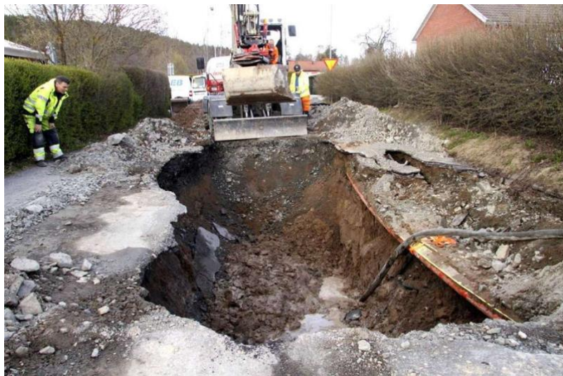
Reparation av vattenläcka pågår. Bildkälla: VA-Fakta
