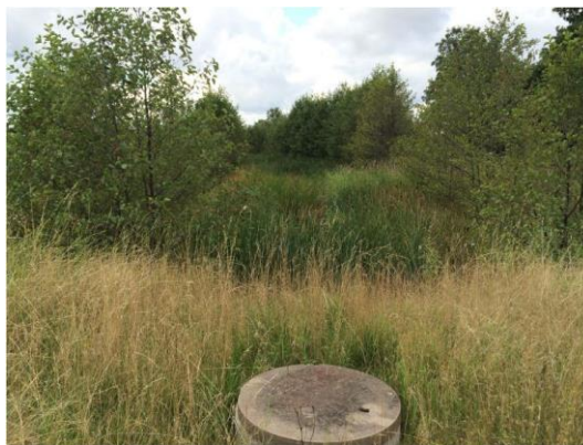
Figur 20. Samma damm vid Storvreta 2014. Dammens vegetation har inte skötts. Dammen har växt igen och förlorat stora delar av sin renande funktion.
