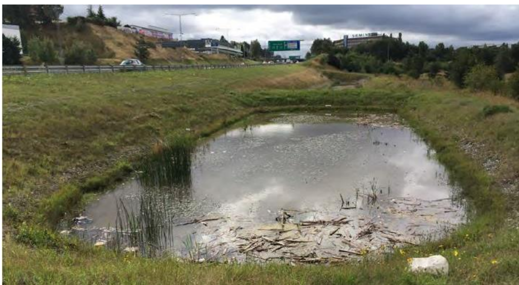
Figur 1. Fördröjnings- och sedimentationsdamm vid Johanneslund, Stockholm. Fotot är taget under inspektion av dammen, 2014.
