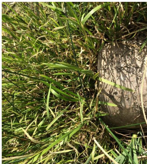
Figur 13. Inloppet på bilden behöver rensas för att inte hindra inkommande flöde. Bilden är tagen i samband med inspektion 2014.
