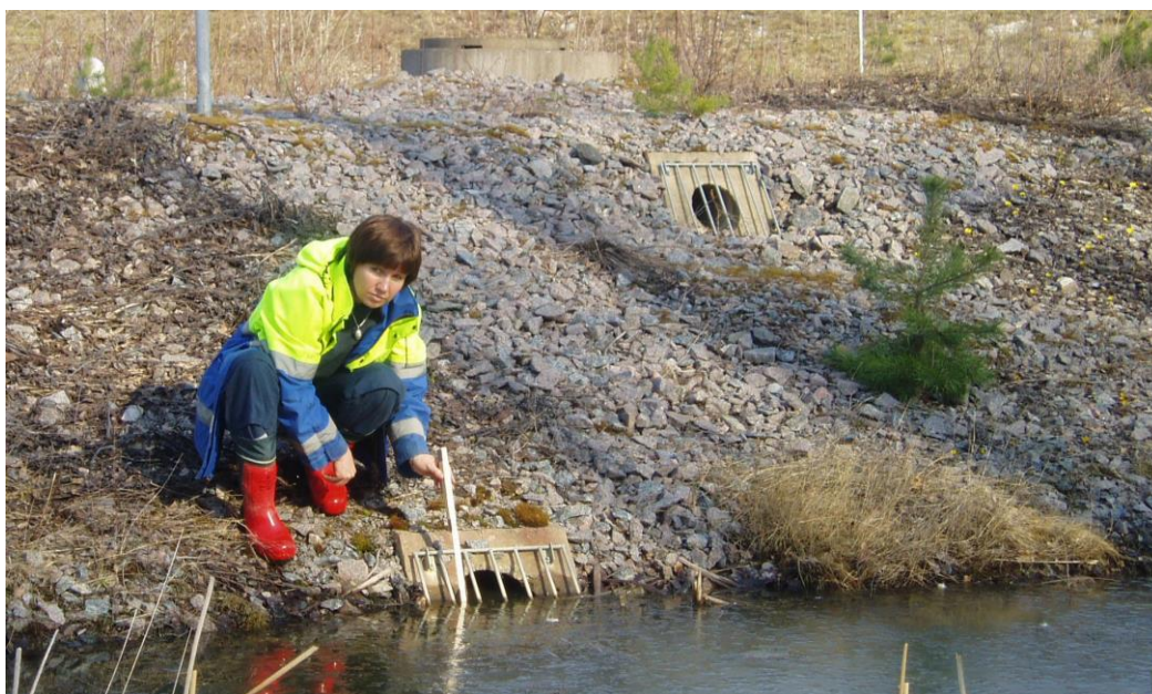
Figur 11. Inspektion och skötselåtgärder ska dokumenteras och återrapporeras till ansvarig person på Trafikverket. På bilden kontrolleras en utloppsbrunn. Foto: SGI
