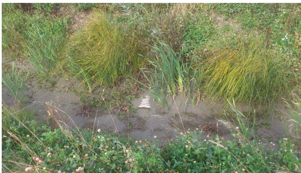
Figur 8. Tillväxt av sediment är snabbast vid inloppet. Inloppet på bilden har blivit helt igensatt av sediment. Bilden är tagen vid dagvattendamm vid Asköbäcken i samband med inspektion 2014.
