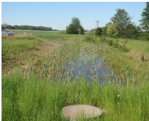
Figur 19. Damm vid Storvreta 2009. Sly har börjat växa upp vid dammens kanter och behöver avlägsnas. Även viss rensning av vattenvegetation behövs.
