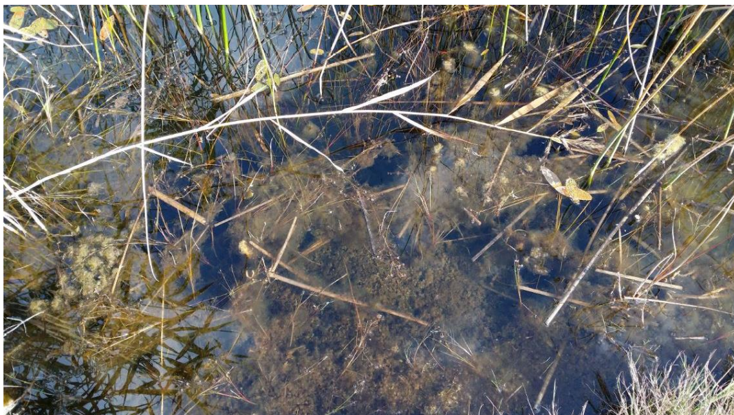
Figur 17. Om vegetationen blir för tät hindras dammens flöde. Vegetationen behöver då rensas. Bilden är tagen vid dagvattendamm i Biskopskvarn i samband med inspektion 2014.
