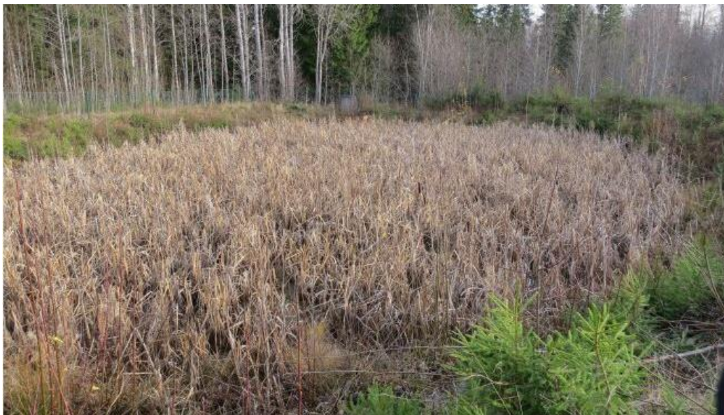
Figur 22. Kraftigt igenvuxen damm vid Karlskoga. Dammens behov behöver utredas. Eventuellt behöver dammen grävas ur för att återställas. Bilden är tagen i samband med inspektion 2014.
