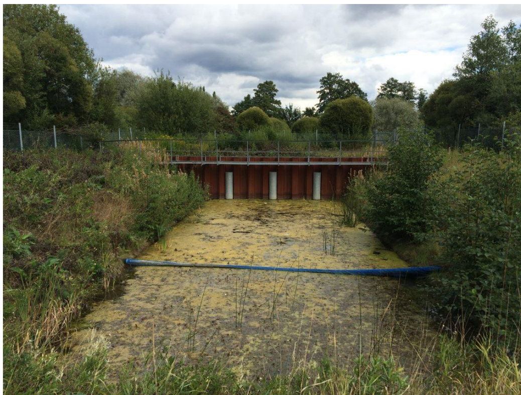
Figur 5. Kraftig tillväxt av makroalger vid dagvattendam vid Fyrisån. Bilden är tagen i samband med inspektion 2014.
