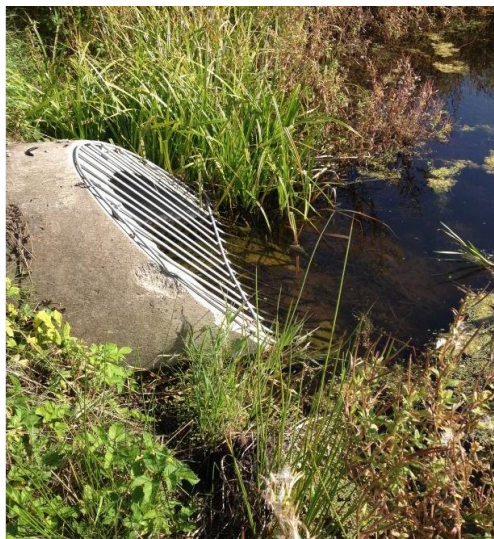
Figur 12. Välskött utlopp vid dagvattendamm vid Norrköping. Bilden är tagen i samband med inspektion 2014.
