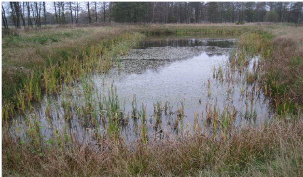
Figur 16. Välskött damm vid Glahytt, Kättebro. Dammens kanter har väl etablerad vegetation utan tuvor och sly. Dammen har vattenväxter, men hotas inte av igenväxning. Inga kanaler har bildats i vegetationen. Dammen är tagen i samband med inspektion 2014.
