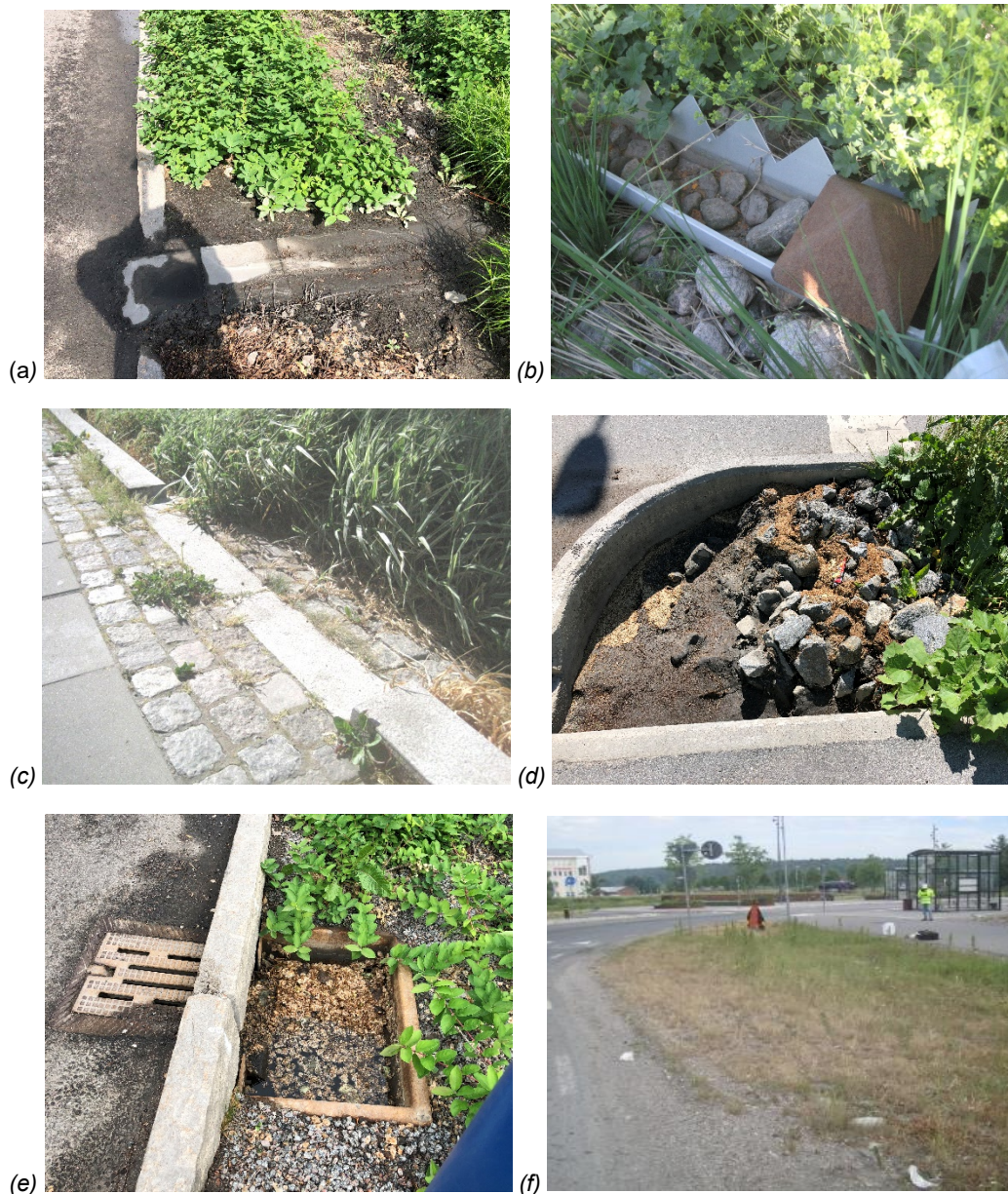
Figur 2. Olika typer av inlopp och försedimenteringar
