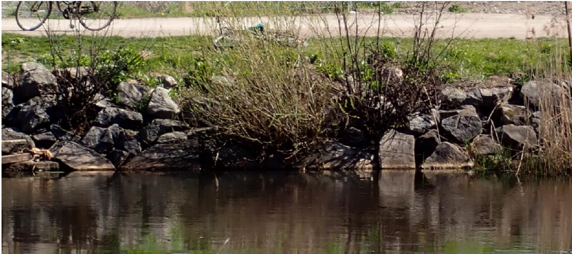
Figur 9. Stenskoning i Fyrisån.
