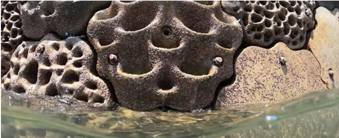
Figur 21. Strukturplattor längst kajkant. Foto: Miljöförvaltningen i Helsingborg stad (2021).
