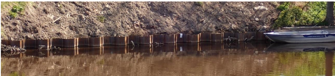
Figur 8. Stålspont i Fyrisån med branta, kala strandlänter.
