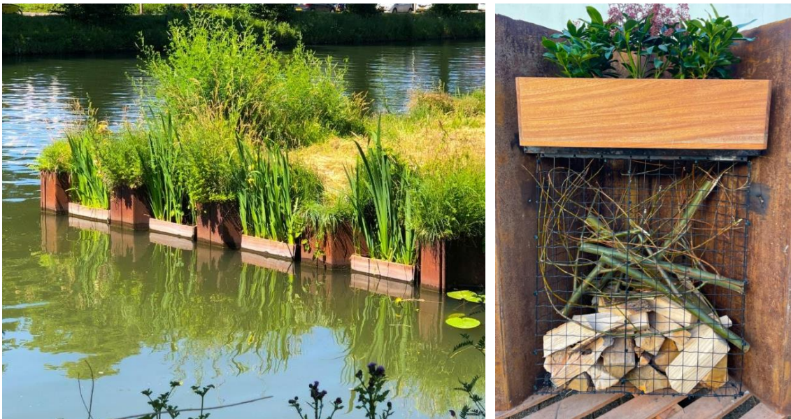
Figur 20. Exempel på strukturer som gynnar organismer. T.v. Spont med planterade växter. T.h. Spont med lådor för växter och nät under vattenytan fyllda med växtmaterial. Foto: Reef Systems (2023).
