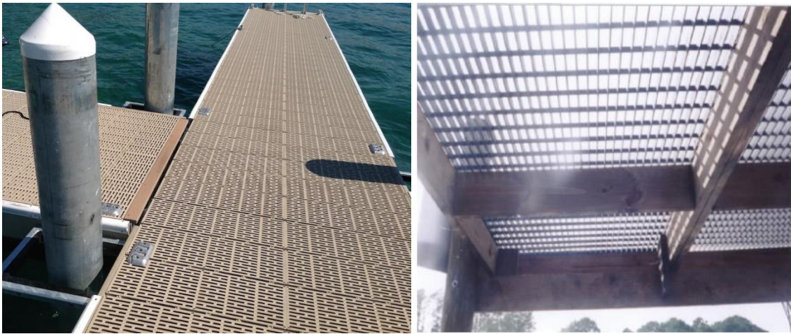
Figur 13. T.v. En typ av bryggkonstruktion med stål- eller aluminiumram. Däcket görs av metall eller polypropen och kan släppa igenom en del solljus (The Dock Company, 2023). T.h. Ljusgenomsläpp i en brygga med glasfibergaller (Shafer, 2002).
