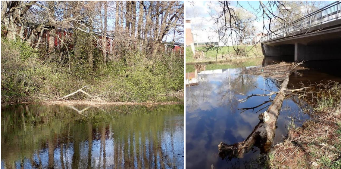
Figur 7. T.v. En sträcka av Fyrisån vid Fyrishov där död ved ligger i vattendraget utan att täcka fåran och hindra flödet. T.h. Ett dött träd har lagt sig horisontellt mot Fyrisvallsbrons mittenpelare och blockerar ena passagen under bron.
