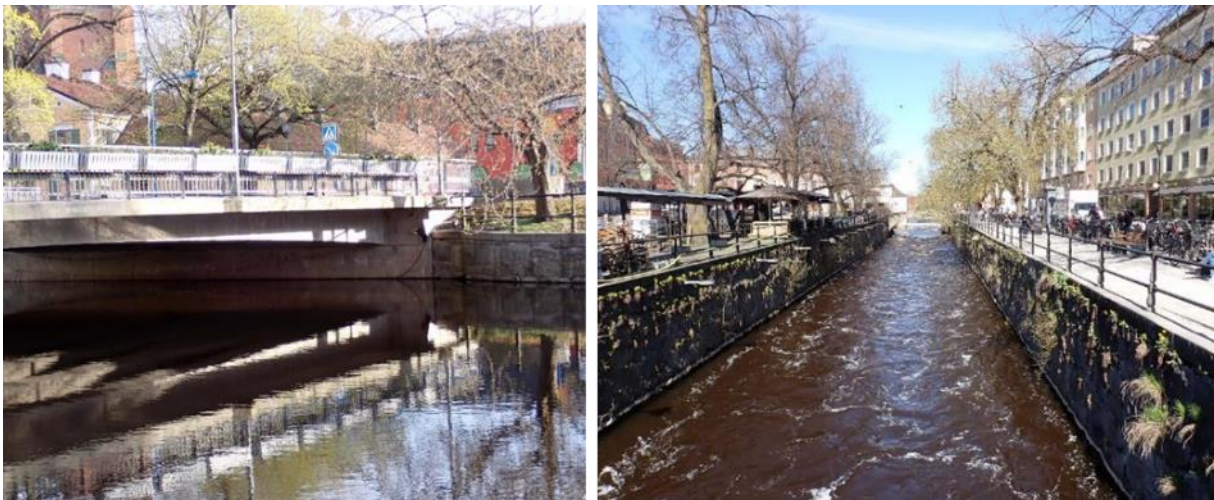
Figur 19. T.v. Exempel på en kal åkant i Fyrisån där färre organismer kan etableras. T.h. En något ojämn stensatt åmur med hålrum ger ändå viss möjlighet för organismer att etablera sig.
