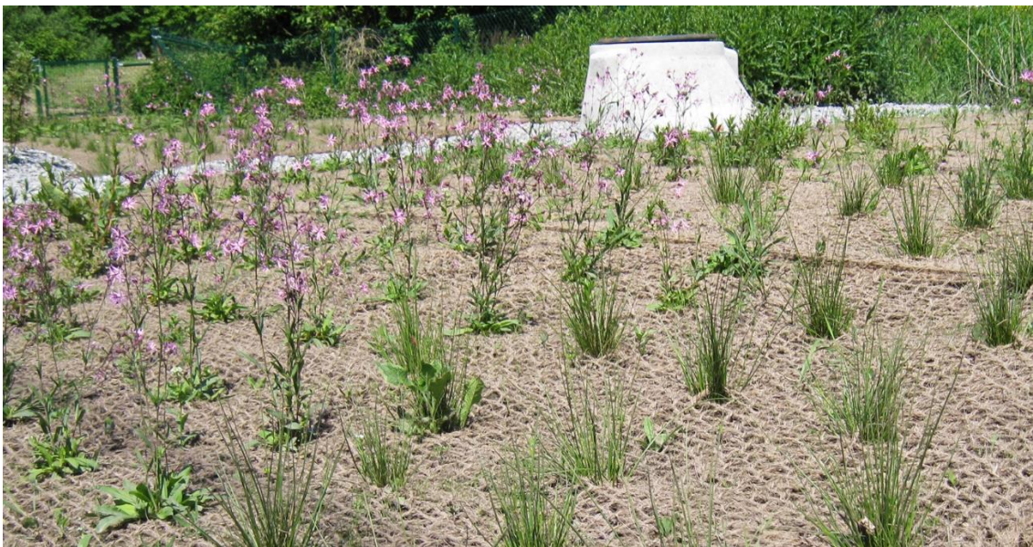
Figur 11. Kokosnät med etablering av växter. Foto: Veg Tech (2023a).
