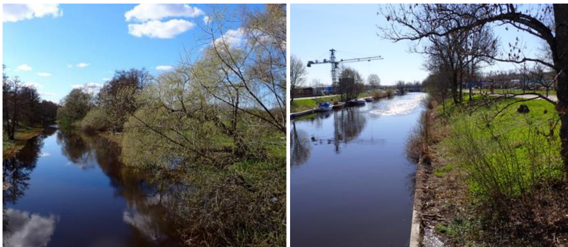
Figur 4. Notera att båda sträckorna av Fyrisån är extremt rätade och sänkta. I fotot till vänster vid Fyrisvallsbron finns dock viss naturlig vegetation och en antydning till svämplan (översvämningssytor). I fotot till höger vid båtvarvet har Fyrisån spontade kanter och bryggor.
