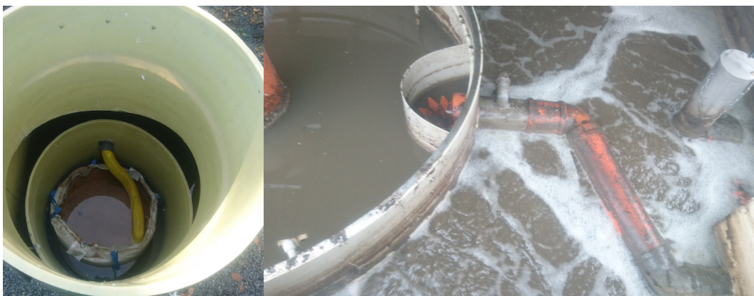
Figur 3. Exempel på en fosforfälla (vänster) och ett småskaligt reningsverk med kemisk fällning och luftning (höger).
