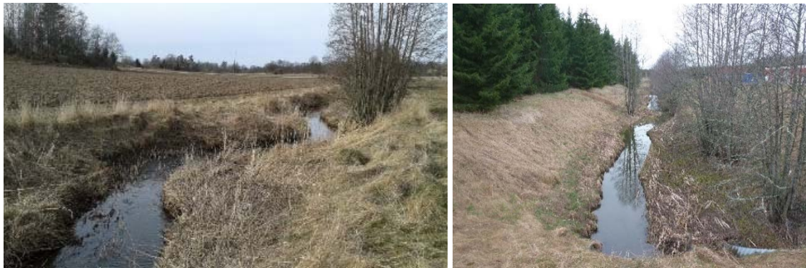
Figur 5-11. Exempel på två sträckor i samma vattendrag där fåran har rätats, men på olika sätt. Vänster foto visar en sträcka som rätats men ej gjorts bredare. Där har sträckan fått ökad specifik flödeseffekt vilket innebär kraftig erosion. Vattendraget tenderar att göra dikessektionen bredare för att få utrymme att meandra och skapa ett nytt svämplan, vilket kommer leda till lägre specifik flödeseffekt på sikt (lägre lutning p g a meandring och högre bredd vid högflöde m h a svämplanet). Höger foto visar en rätad sträcka där bäcken gjordes fyra gånger så bred, vilket minskade flödeseffekten. På den sträckan har istället sedimentationsprocesser lett fram till att vattendraget blivit smalare och att ett nytt svämplan byggts upp inom dikessektionen. Sedimentationsprocessen har också byggt upp en grundare fåra med högre lutning. Ökade lutningen och den smalare bredden innebär att vattendraget har ökat specifika flödeseffekten jämfört med när diket var nygrävt.
