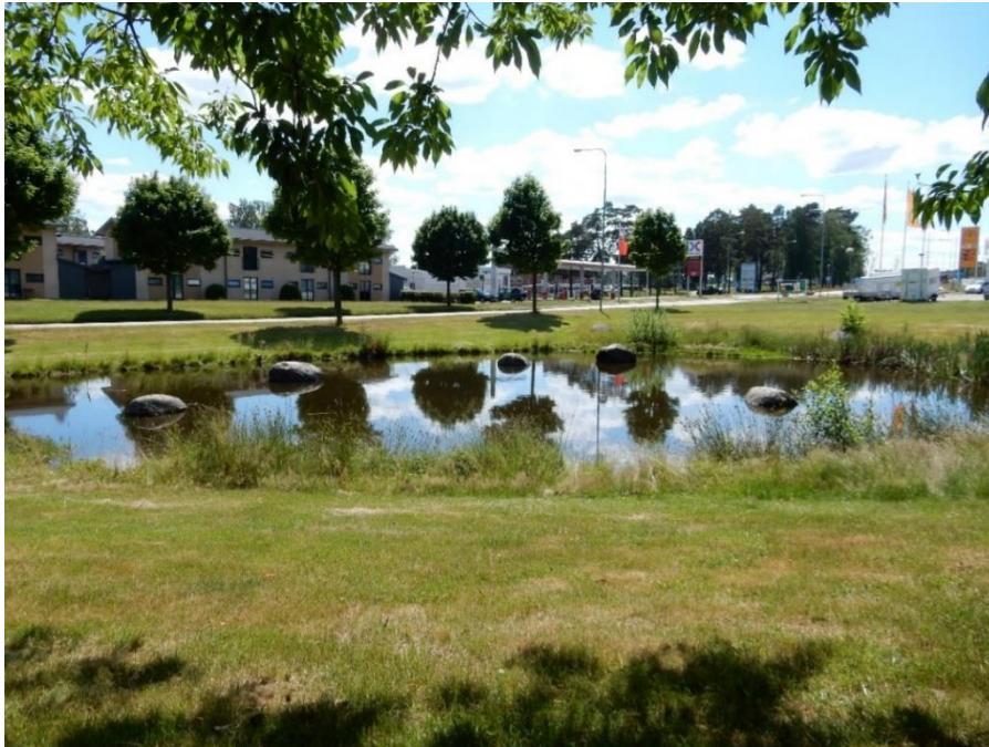
Figur 13. Dagvattendamm vid Helsingborgsvägen i Ljungby.
