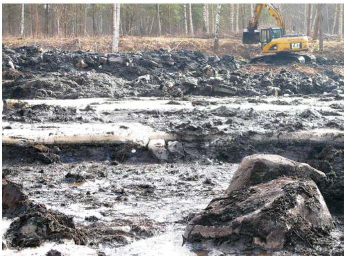
Under byggtiden ser det ofta ut som ett månlandskap och det kan vara svårt att föreställa sig slutresultatet. Här har man valt att gräva på tjälad mark eftersom jorden var torvrik och instabil.
