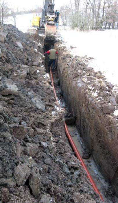
Rör är viktiga att lägga plant. Utmed nedre halvan av rörsidorna ska jorden packas med fottramp.
