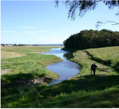
En grund och långsmal våtmark fungerar bra som näringsfälla.
