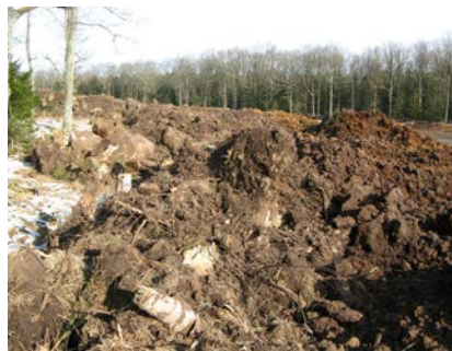
Schaktmassor bör antingen jämnas ut eller "gömmas" i landskapet, till exempel mot ett skogsbryn.
