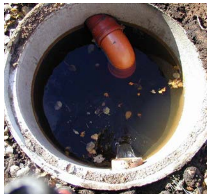
En rensbrunn mellan vattenintaget från bäcken och våtmarken håller inloppsledningen fri från löv och skräp.
