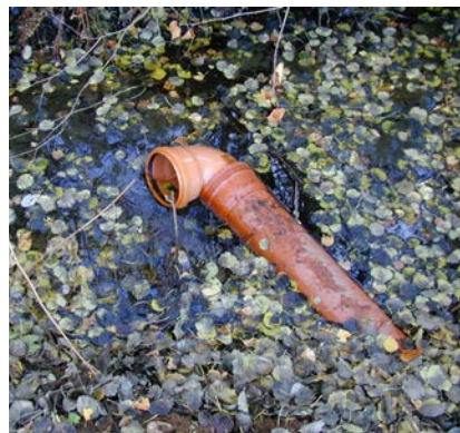
En böj på inloppsröret i bäcken gör att kvistar inte dras in i röret.
