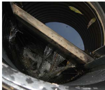
Träplankor är ofta inte täta och kärvar, vilket försvårar arbetet med att hålla vattnet på önskad nivå.
