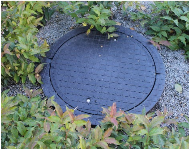
Brunn med sandfång kopplat till ett tätt krossmagasin.
