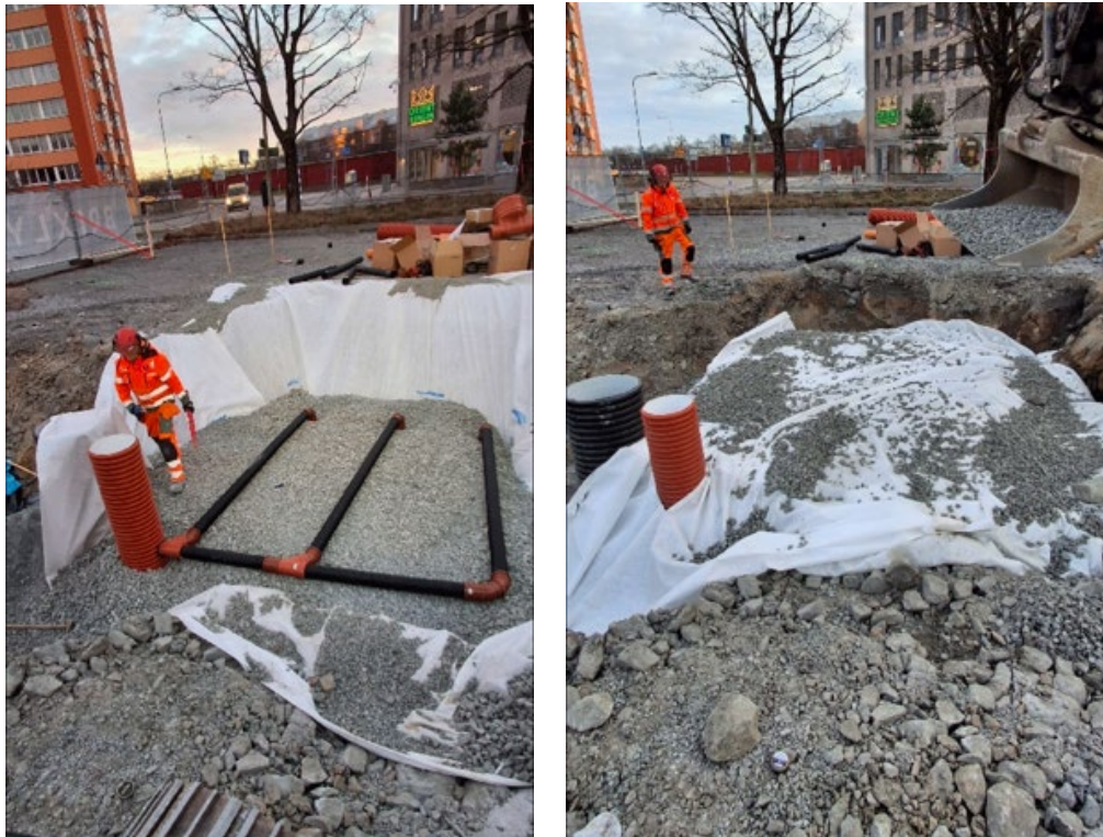
Ett krossmagasin som placeras under mark för fördröjning av dagvatten.
