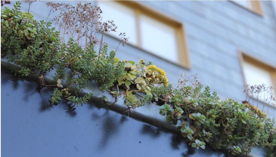
Sedumtak på ett miljöhus på Litteraturgatan, Göteborg.
