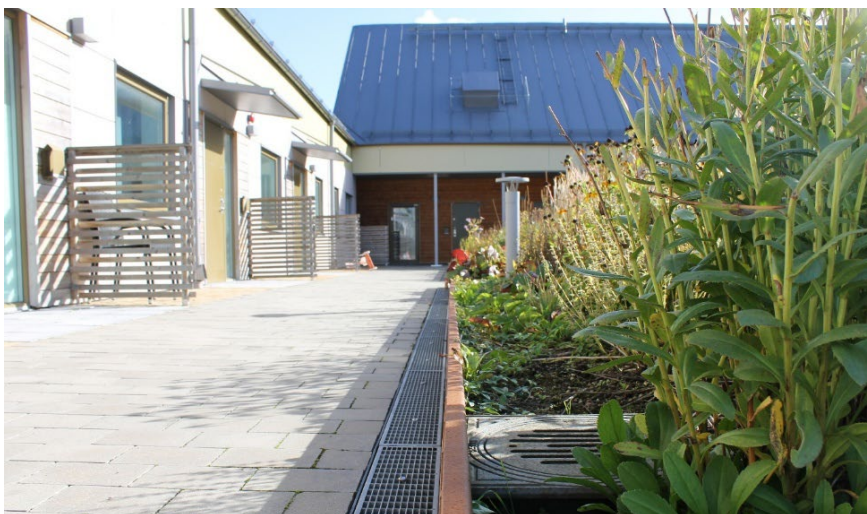
Bjälklag på våningsplan 5, Litteraturgatan i Backa där markrännor leder dagvattnet in i bäddarna.
