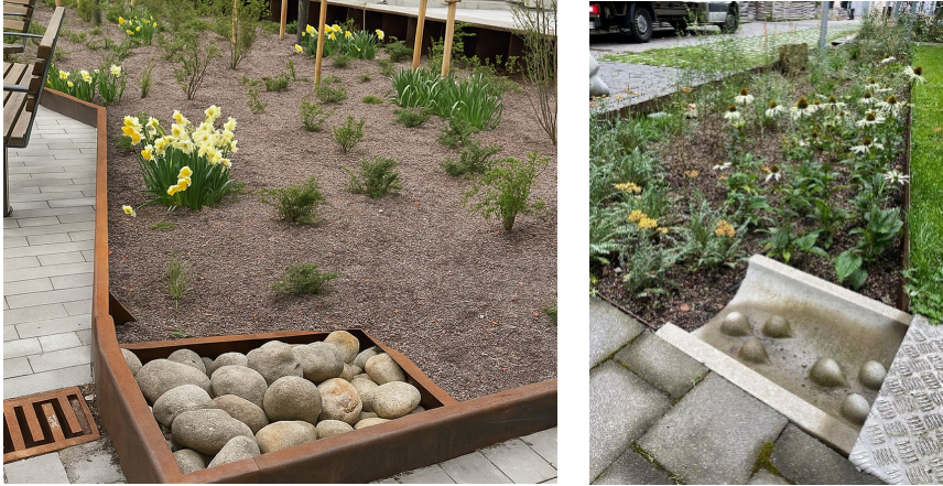
En nedsänkt växtbädd på ett av torgen på utbyggnadsprojektet Täby park utanför Stockholm (TV) samt en på en bostadsgård på Mandolingatan i Göteborg (TH).
