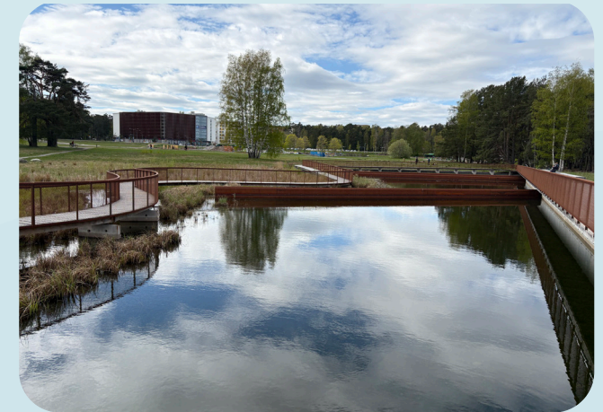
Damm vid Polacksbacken , Uppsala. Observera att ett sådant utförande med stål och betongkonstruktioner skulle ge ett helt annat klimatavtryck än det i beräkningsexemplet.
