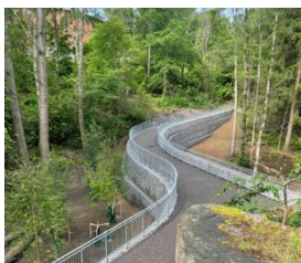
Bild 3. Färdigställd skyfallsanläggning i Stabbeparken. Bild från Göteborgs stad.
