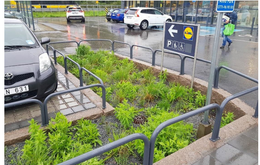
Figur 2. Införsel av dagvatten via nollad kantsten i Sigtuna Stadsängar. Foto: Fredrik Ohls
