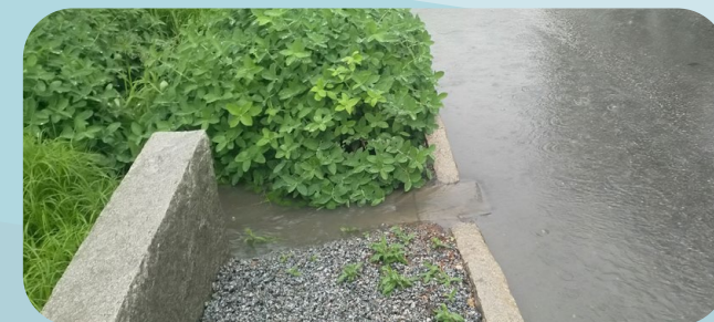
Figur.7 Inlopp via sänkning av kantsten
