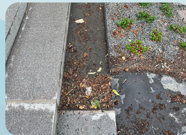
Figur.13 Plattor som erosionsskydd
