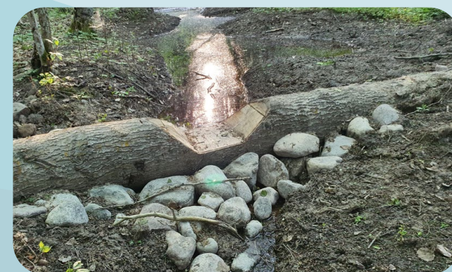
Figur.20 Dämme med bräddningsfunktion.
